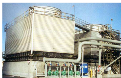
Energeticky náročnější avšak prostorově menší chladiče mají v kratších komínkách umístěny vrtulové ventilátory
