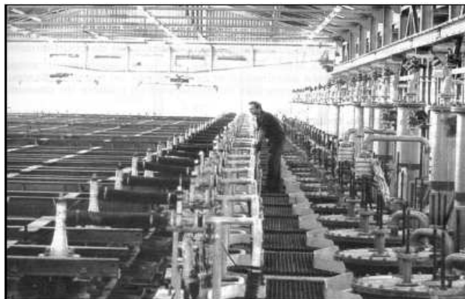
Hala s amalgámovými elektrolyzéry
