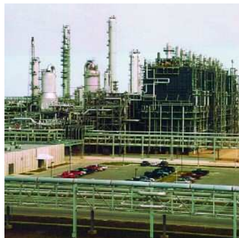
Výrobní ethyleny. Krakovací jednotka je uvnitř konstrukce napravo, destilační kolony v pozadí slouží pro separaci produktů.
