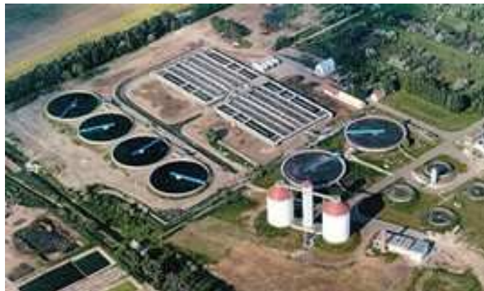
Letecký pohled na čistírnu vody pro 200 tis. obyvatel. Aktivační nádrže obdélníkové vzadu. Kruhovité Dorrovy dosazovaky. Uzavřené válcové věže – vyhnívání
