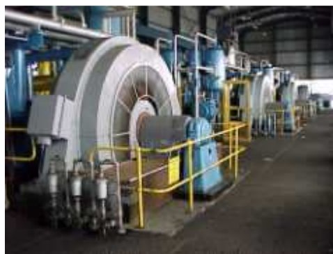
Kompresory na stlačení syntézního plynu
