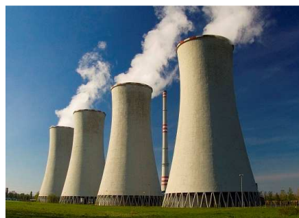
Chladicí věž. V dolní části je mřížová, kropená chladenou vodou. Lehčí horký vlhký vzduch stoupá vzhůru a přisává spodem nový suchý vzduch. (Dětmarovická elektrárna)
