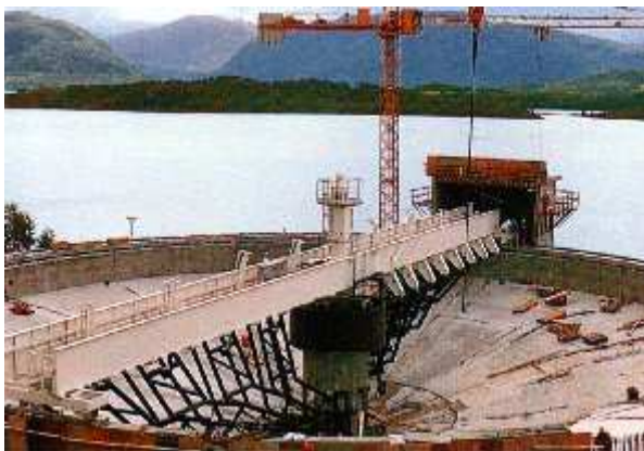
Dosazovací nádrž typu Dorrův usazovák ve výstavbě. Je to velká kruhová nádoba, na níž se pomalu otáčí most, který shrabuje plovoucí nečistoty z hladiny a současně ponořenými hrably shrnuje usazený kal k výpusti uprostřed dna. Směs přitéká středem a vyčištěná voda se sbírá na obvodu nádoby
