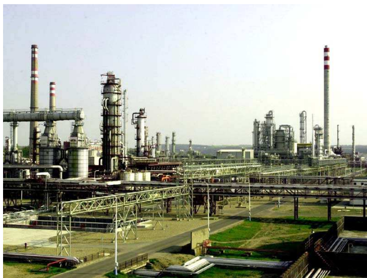
Kolony pro destilaci ropy v Kralupské rafinerii. Rafinerie a petrochemické závody udržují z požárních důvodů značný rozestup mezi jednotlivými provozny.
