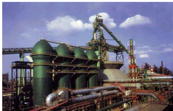
Vysoká pec v pozadí, zprava k ní vede výtah na kusové suroviny, vepředu 4 cowperry pro přehřev vzduchu
